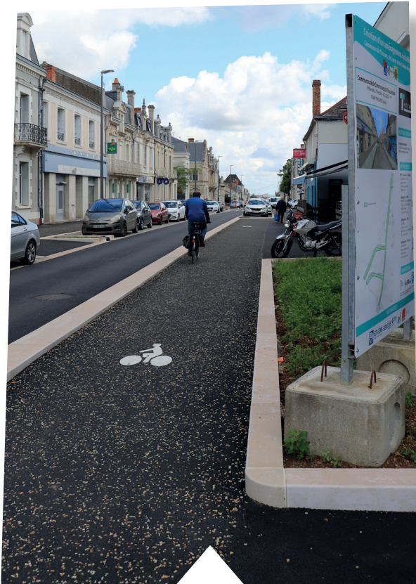
Travaux achevés pistes cyclables Avenue Victor Leclerc
